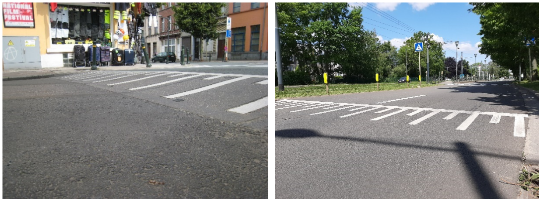
Figure 4 : Forme des rampes d'un plateau (sinusoïdale ou plane)
