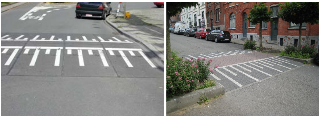
Figure 5 : Ralentisseur de trafic composé d'éléments préfabriqués (à gauche) et de pavés (à droite)
