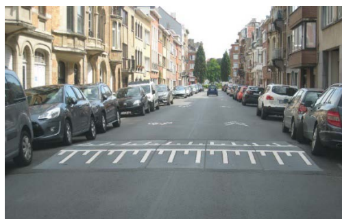
Figure 57 : Marquage en peigne sur les rampes (les traits longitudinaux ont une largeur de 0,10 m environ; les traits longs ont une longueur de 1 m environ; les traits courts ont une longueur de 0,40 m environ; l'espace entre deux traits est d'environ 0,20 m; le trait blanc transversal a une largeur d'environ 0,20 m).
