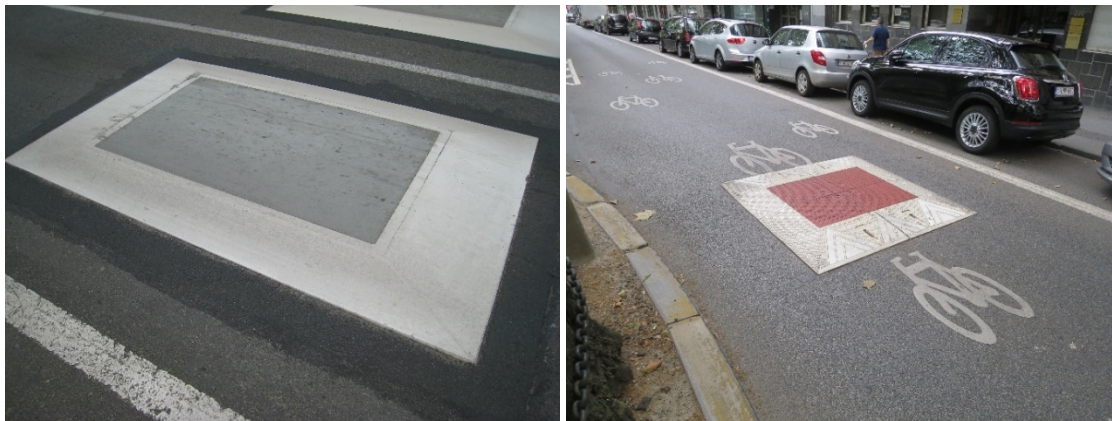
Figure 104 : Illustration des deux types de modes de pose de coussins ralentisseurs
