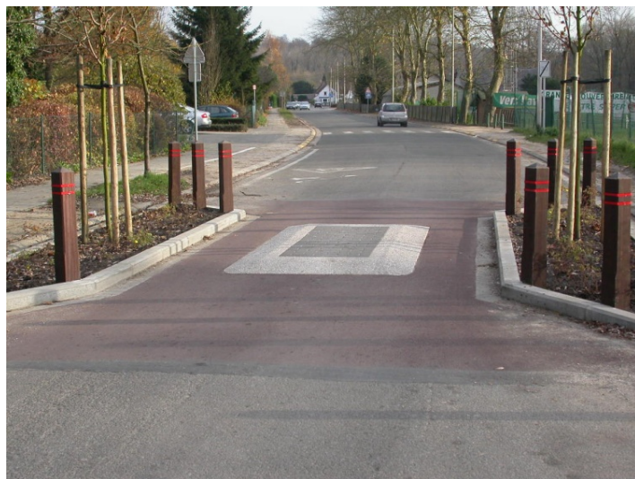
Figure 64 : Coussin associé à un rétrécissement de la voirie : chaussée < 5 m à sens unique (à gauche), chaussée < 6 m à double sens (à droite)
