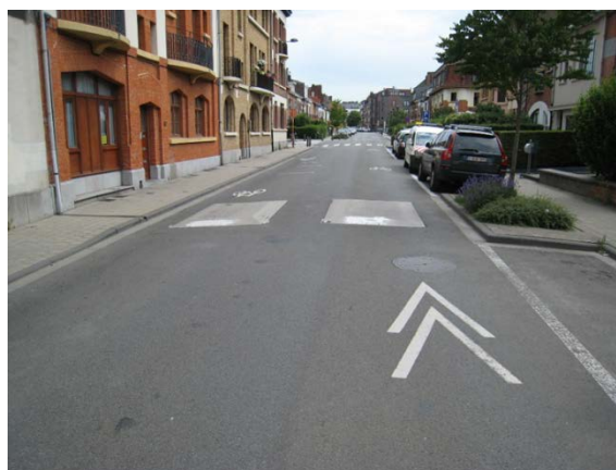
Figure 25 : Aménagement de l'accotement pour empêcher le stationnement à hauteur des coussins (exemple d'une chaussée d'une largeur de 6,20 m ; nb. une ligne blanche continue est manquante à mi distance entre les deux coussins)
