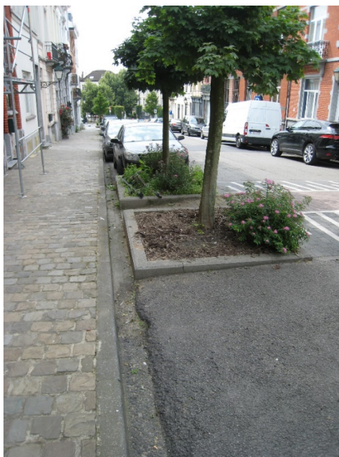
Figure 54 : Aménagement d'îlots latéraux préservant les filets d'eaux à hauteur d'un ralentisseur
