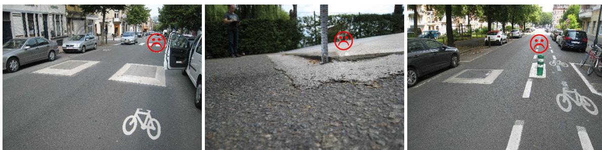
Figure 14 : Illustration de quelques aménagements du type coussins susceptibles d'impacter négativement la sécurité des cyclistes
