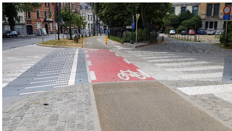
Figure 42 : Passage piéton et traversée cyclable surélevés au débouché de l'av. de la Chevalerie à Etterbeek
