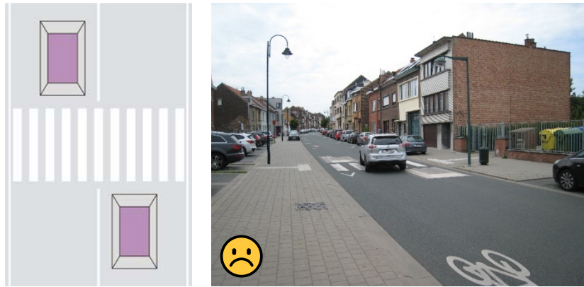
Figure 69 : Risque de comportement inapproprié en présence de coussins en chicane sans séparation physique
