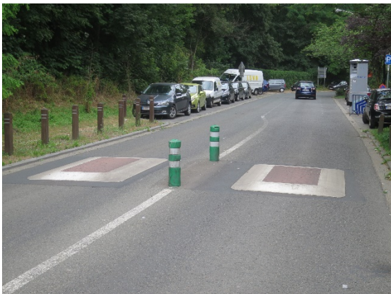
Figure 6 : Coussins placés côte à côte sur une chaussée de 6,90 m de largeur
