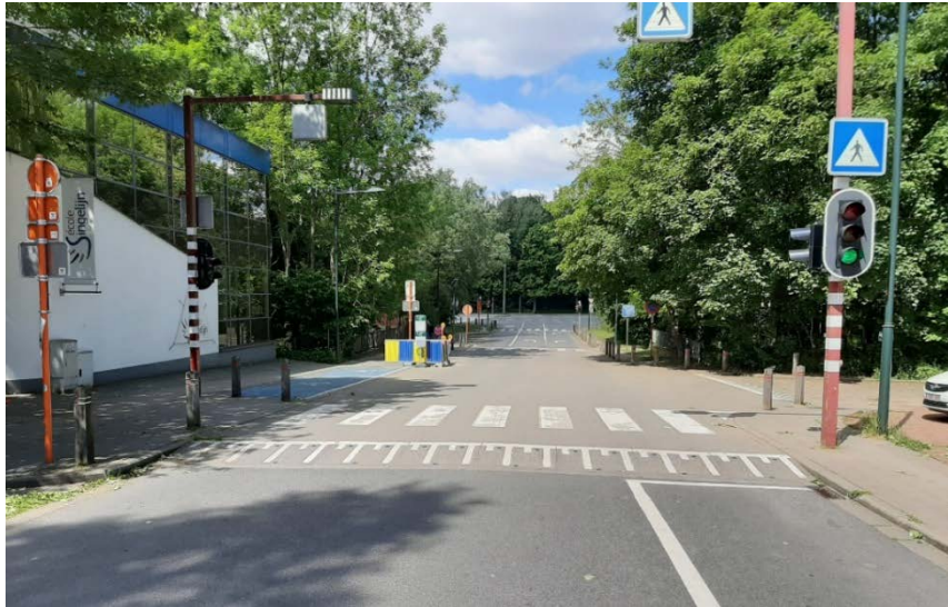
Figure 35 : Plateau en section supportant des passages piétons à l'abord d'une école et au débouché d'une voie verte (Avenue Chapelle-aux-Champs - Woluwe-Saint-Lambert – Réseau Auto plus)
