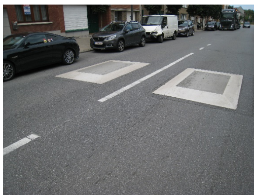
Figure 18 : Exemple d'implantation de deux coussins côte à côte ; illustration sur une chaussée dont la largeur est comprise entre 6 m et 7,2 m (coussins séparés par une ligne blanche continue \geq 10 m)
