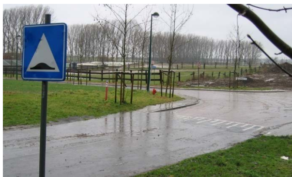
Figure 82 : Des dispositions sont nécessaires pour s'affranchir de soucis liés à l'infiltration des eaux de ruissellement
