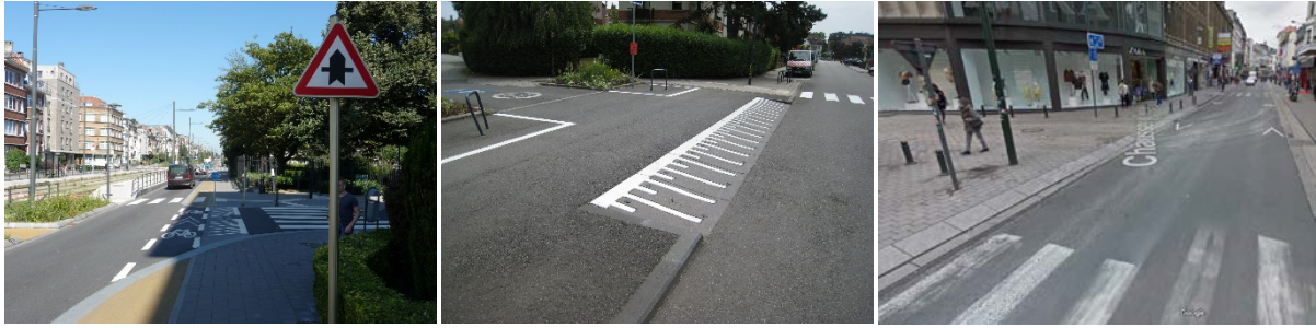
Figure 39 : Illustration de divers types d'aménagements surélevés installés en prolongation des trottoirs ou aménagements cyclables
