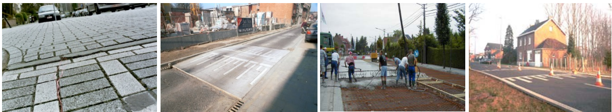
Figure 75 : Différents types de matériaux (pavages, éléments préfabriqués en béton, béton coulé en place, revêtement bitumineux) utilisés pour la construction des ralentisseurs, plateaux ou coussins
