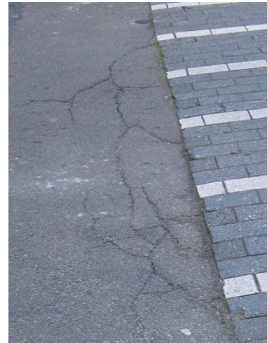
Figure 89 : Nécessité de prendre des dispositions pour gérer l'infiltration des eaux de ruissellement dans un pavage
