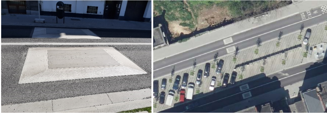
Figure 67 : Installation de deux coussins côte à côté sur une chaussée à deux voies dans la même direction (avenue de la Liberté – Koekelberg)
