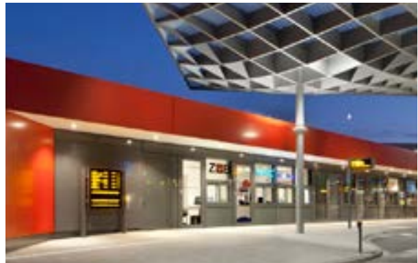
Perrons en verkoopruimten (station van Hannover)
